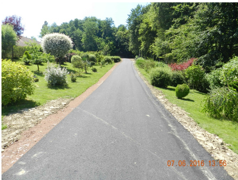
Slika 22: asfaltirana JP 703 315 Sr. Gasteraj - Repa
