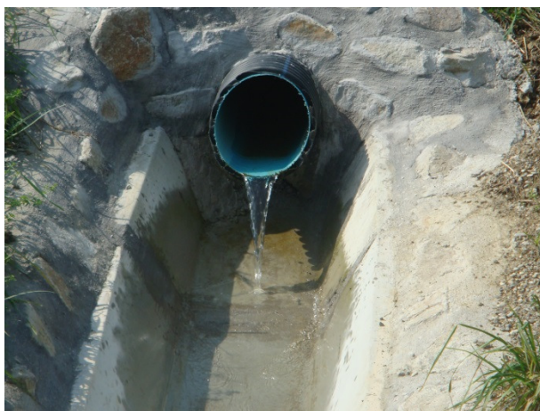
Slika 7: Vzdrževanje kanalizacijskega sistema (iztok vode iz čistilne naprave)
