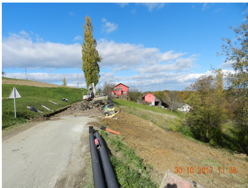
Slika 25: Sanacija plazu na Žitencah
