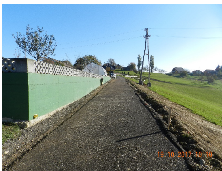
Slika 24: Cesta JP 703 403 pred asfaltiranjem
