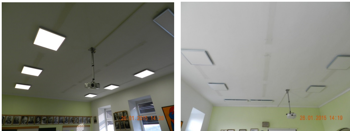
Slika 9: Nova, energetske varčna svetila v šoli
