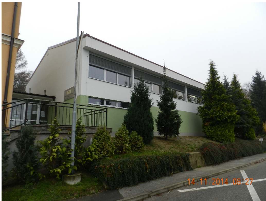
Slika 24: Telovadnica OŠ J. Hudalesa pred obnovo
