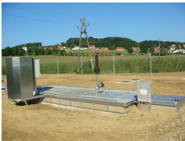
Slika 22: Čistilna naprava v Jurovskem Dolu (foto: arhiv občine)
