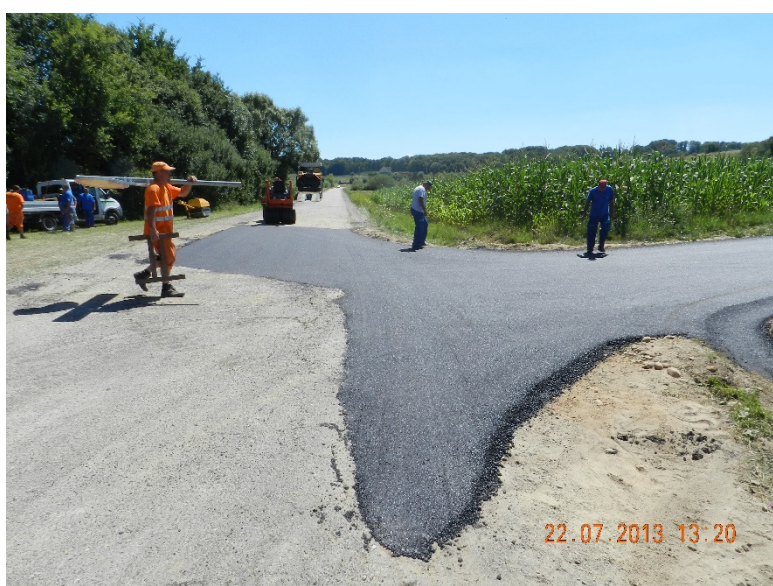
Slika 21:Asfaltiranje ceste JP 705 340 Malna – Zelenko (foto: arhiv občine)
