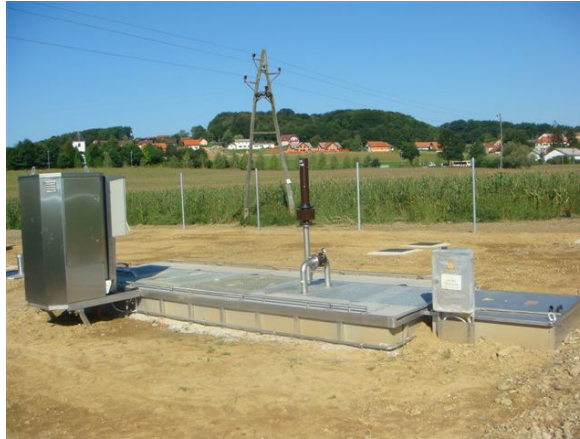
Čistilna naprava v Jurovskem Dolu (foto: arhiv občine)
