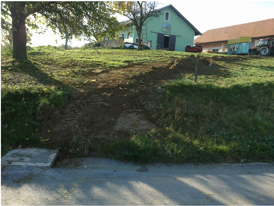
Jurovska cesta - odvodnjavanje
