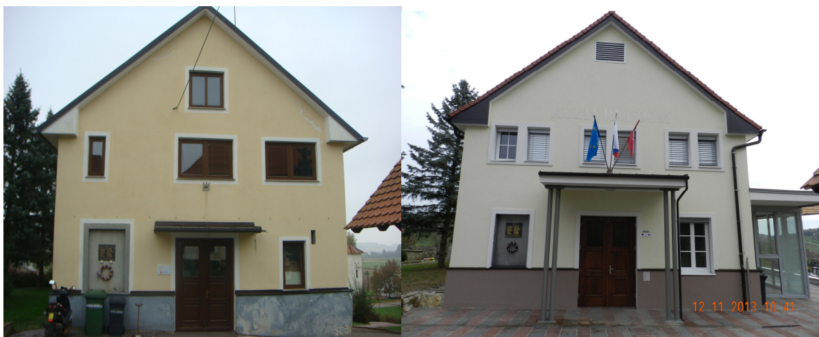
Slika 6: Kulturni dom Jurovski Dol pred in po obnovi
