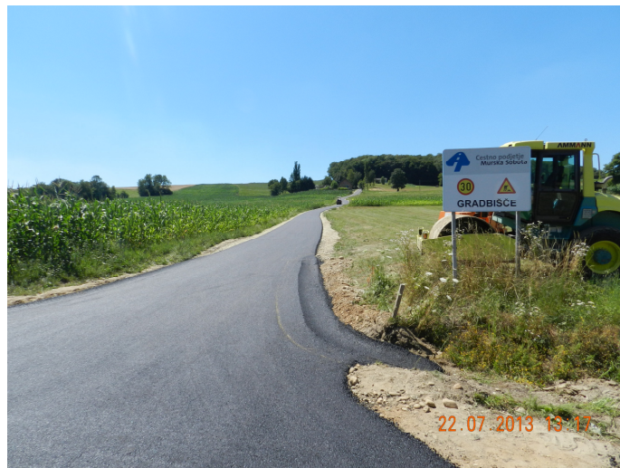
Slika 8 : »Rekonstrukcija občinskih cest 2012-2013 – ZFO«,
