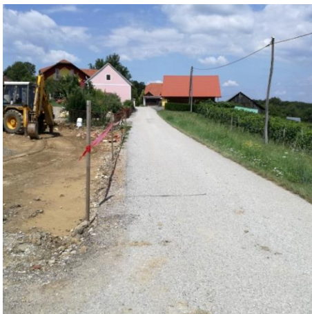
Primer: poseg v varovalni pas občinske ceste
