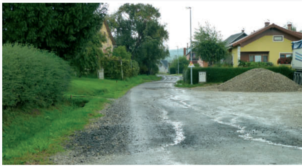
Odstranjeni dotrajani asfalt bodo zamenjali z novim
