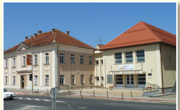
○ Obnovljeni Dom kulture Lenart za naslednja desetletja
