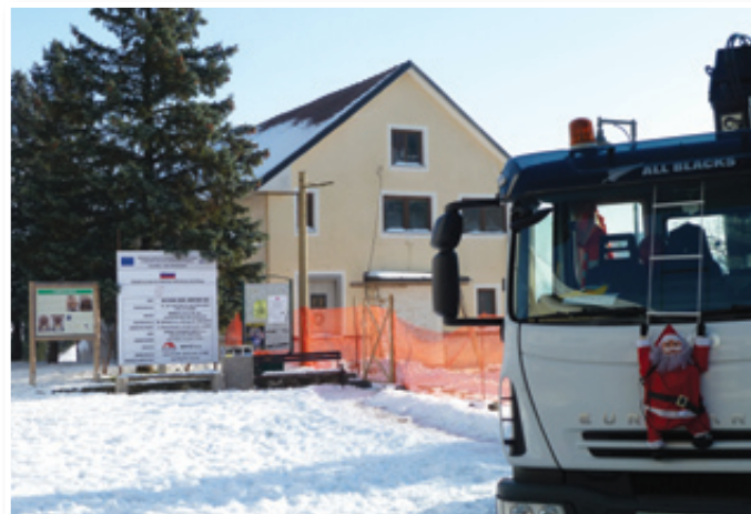
Kulturni dom so začeli obnavljati
