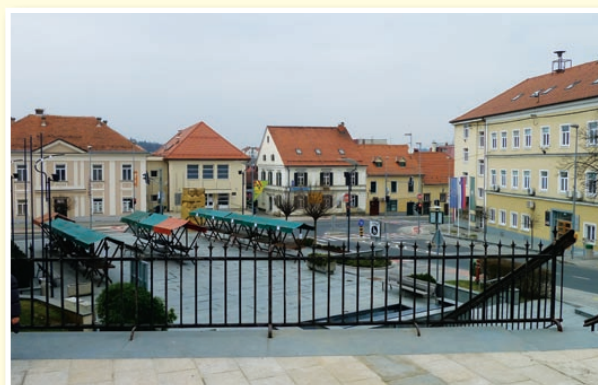
○ Lenart: načrti živijo; obeta se tudi naložba v energetska sanacijo osnovne šole.
