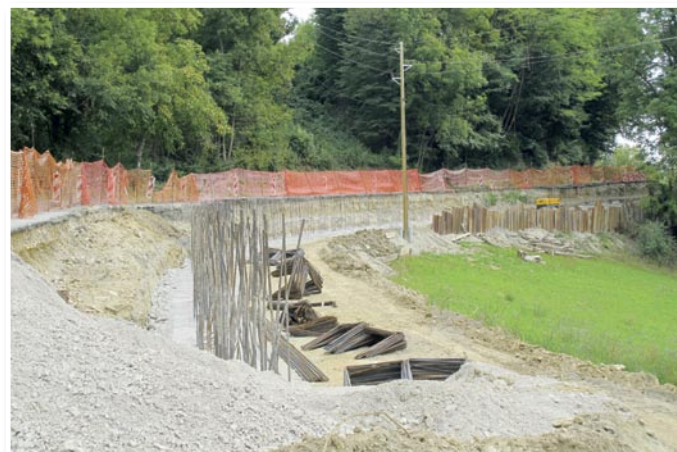
Sanacije plazov, ki je poškodoval ceste na klancu med Sveto Trojico in Zgornjim Porčičem ter Lenartom, so se tokrat lotili zares temeljito. Ob cesti bodo zgradili tudi pločnik.
