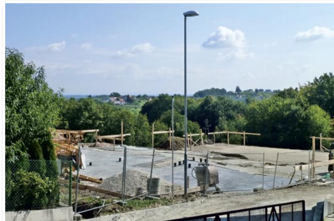
Zemeljska dela za izgradnjo petoddelčnega nizkoenergetskega vrtca v Cerkvenjaku so že končana.
