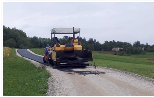
Cestno podjetje Pomgrad prejšnji teden pričelo z asfaltiranjem ceste v Sp. Gasteraju.
