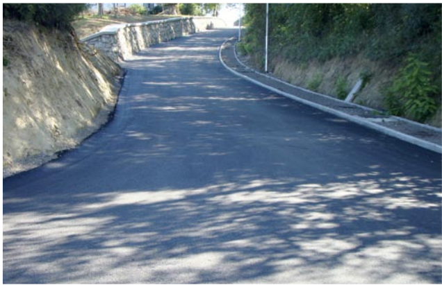
Obnova ceste z javno razsvetljavo v naselju Kremberk, foto: Viktor Kapl
