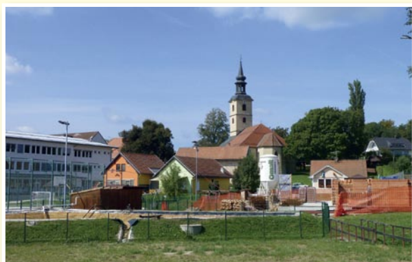
○ V Benediktu so ob starem vrtcu že začeli rasti zidovi novega 7-oddelnega vrtca.
