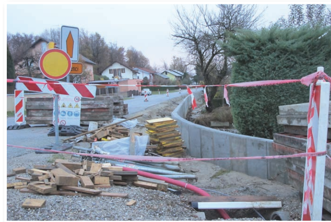
Izgradnja pločnikov in sanacija regionalne ceste Cerkevjak–Sveti Jurij ob Ščavnici v Cerkevjaku od križišča pri pokopališču do kapele pri granati že intenzivno poteka.
