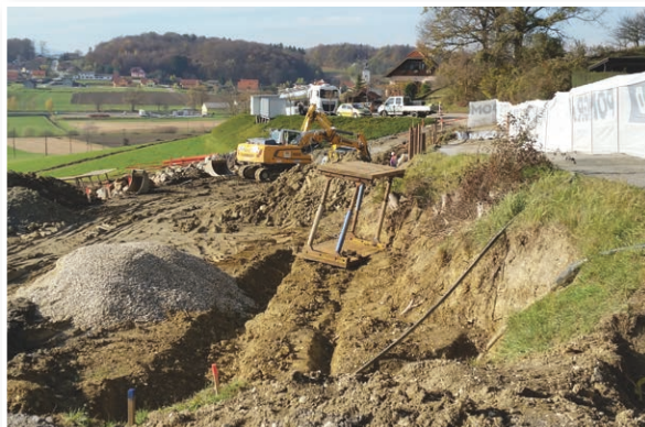
Sanacija plazu na cesti Jurij Lenart se nadaljuje...
