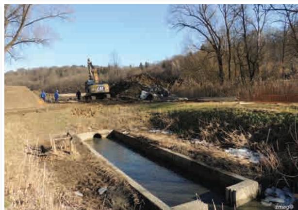
Odkopani del nasipa z izlovno jamo
