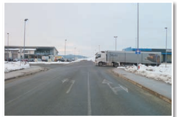
Začetek navezovalne ceste v industrijski coni
