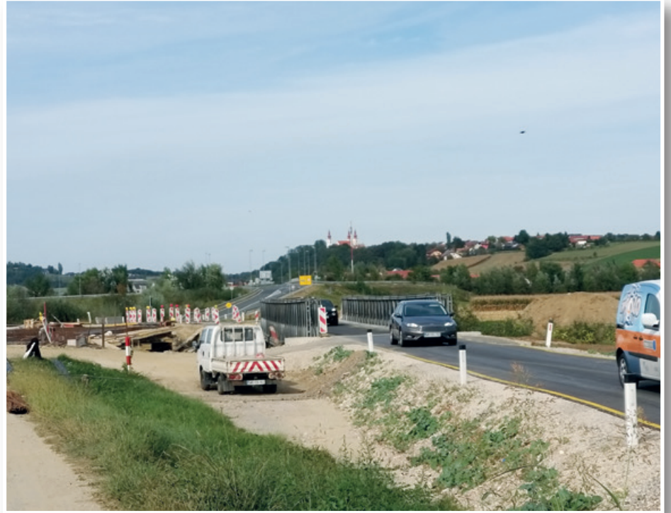
Na državni cesti Lenart–Ptuj proti Gočovi v trojiški občini poteka gradnja novega mostu čez reko Pesnico, saj starega ni bilo mogoče sanirati. Ostali so le deli temeljev in stebrov. Za zagotovitev prometa so morali postaviti začasni nadomestni most z izmenjujočim enosmernim prometom. Foto: E. Pukšič
