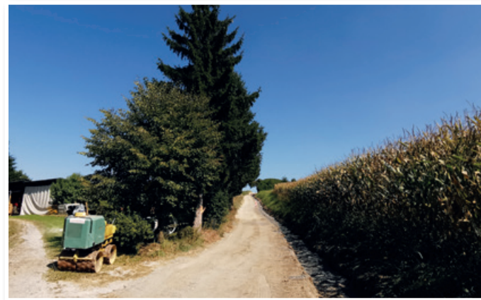
Zemeljska dela na cesti v Sp. Partinju
