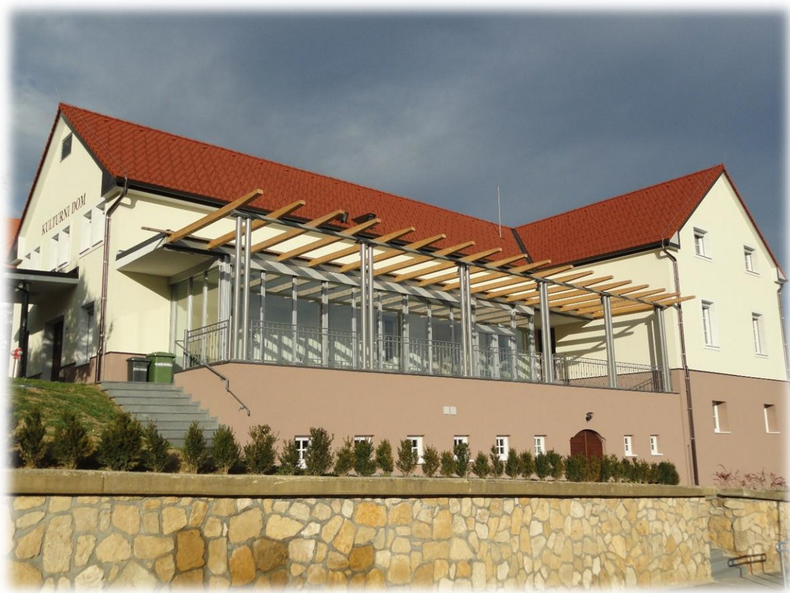
Slika 618: Dograjen in obnovljen kulturni dom, 26. oktober 2013.
