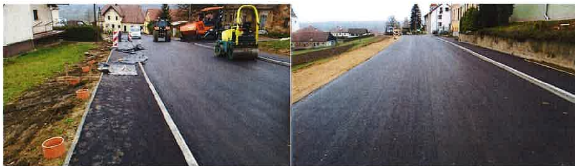
Slika 29: Dela na projektu Ureditve prometne varnosti v Jurovskem Dolu (avtor fotografij: L. Friš)
