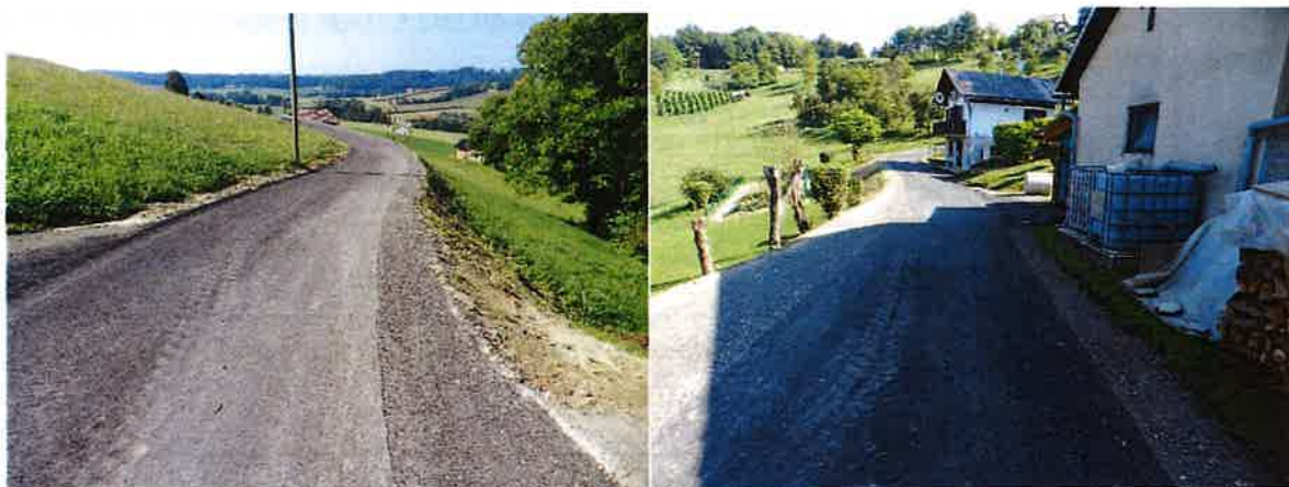
Slika 27: Na novo asfaltirana cesta v Zg. Gasteraju (Žunkovič)
