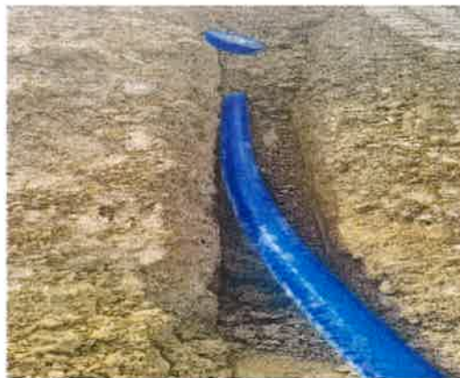
Slika 12: rekonstrukcija cevovoda Lenart – Jurovski Dol
