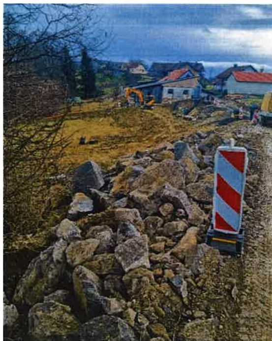
Slika 6 : Sanacija plazu na Žitencah
