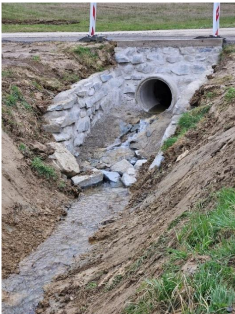
Slika 13: dela pod mostom na JP 703 321
