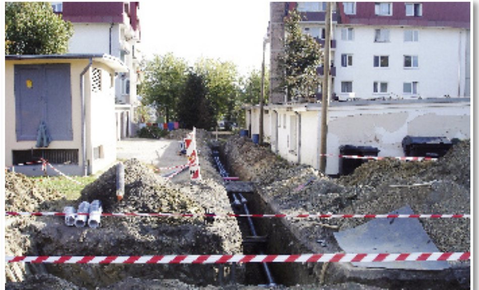
Toplovodni sistem na biomaso v izgradnji
