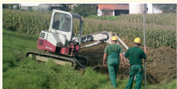
○ Sv. Ana: izgradnja čistilne naprave in kanalizacijskega omrežja v Lokavcu
