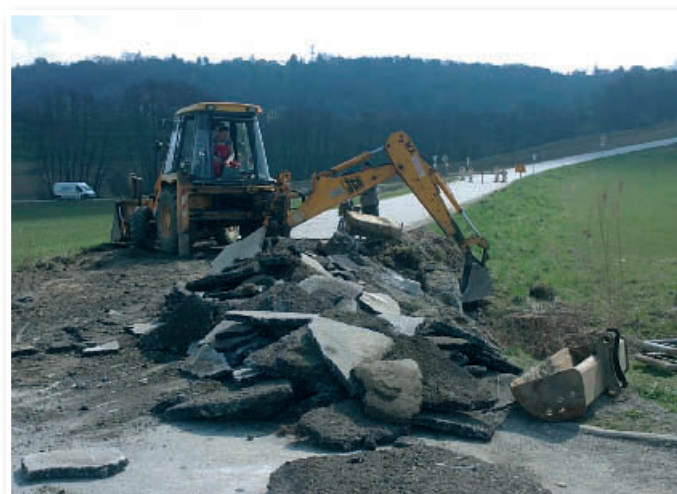
Obnova mostu v Voličini; glavna cesta Lenart-Selce-Ptuj bo zaradi obnove mostu zaprta mesec in pol
