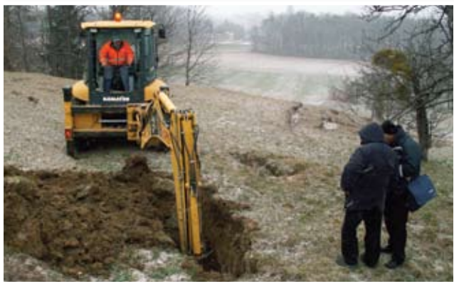
Dela pri sanaciji plazov pri poslovno-obrtni coni so stekla že lani (Foto: arhiv občine)
