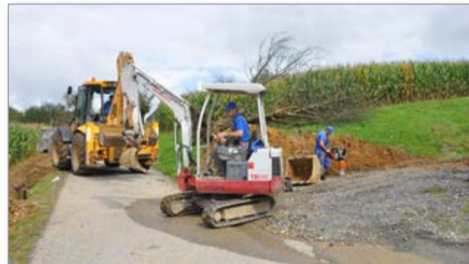
V Rožengruntu so na trasi dolžine 700 m razveselili z vodovodnimi cevmi, ki čakajo na priključitev, ter s položenimi vodi za optiko. Kljub muhastemu vremenu so dela potekala nemoteno, nadvse pomembne pridobitve pa se je razveselilo 19 prebivalcev naselja Rožengrunt.
