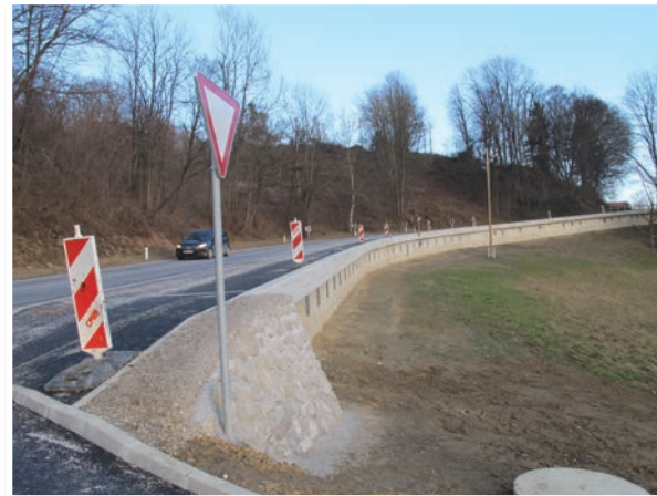
Klanec je po sanaciji dobil povsem nov videz.
