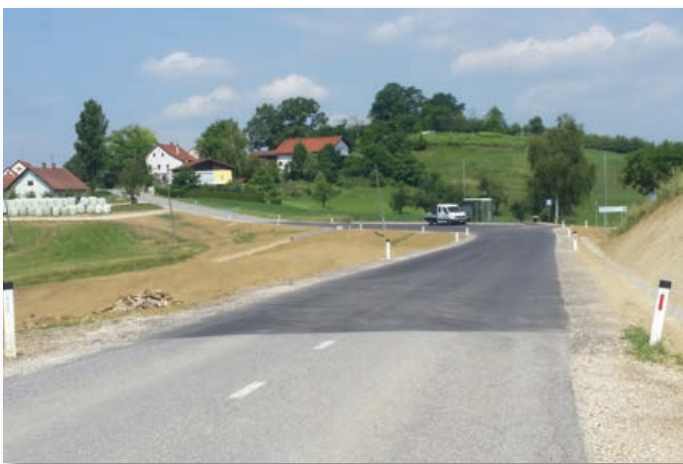
Zaključek sanacije plazu Jurovski dol 2
