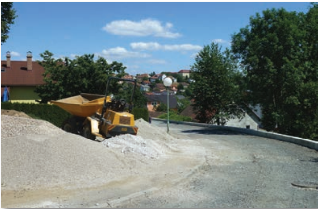
Gradbena dela v Prešernovi ulici
