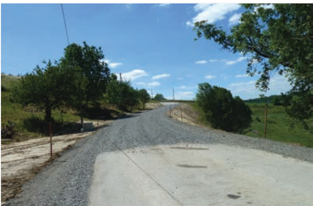
Sanacija plazu ob cesti Lenart–Zavrhu
