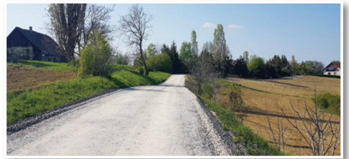
Cesta v Zg. Partinju – odsek Najdenik – pripravljena na asfaltiranje.
